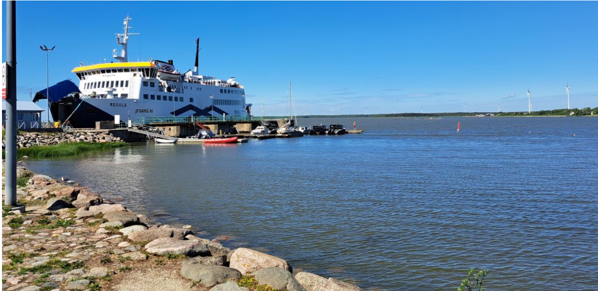
Joonis 3. Regula on sildunud kai nr 6 äärde (betoonist paalid), näha on ka olemasolev väikelaevasadam ujuvkaidega. Foto: ELLE, 2024 juuni.
